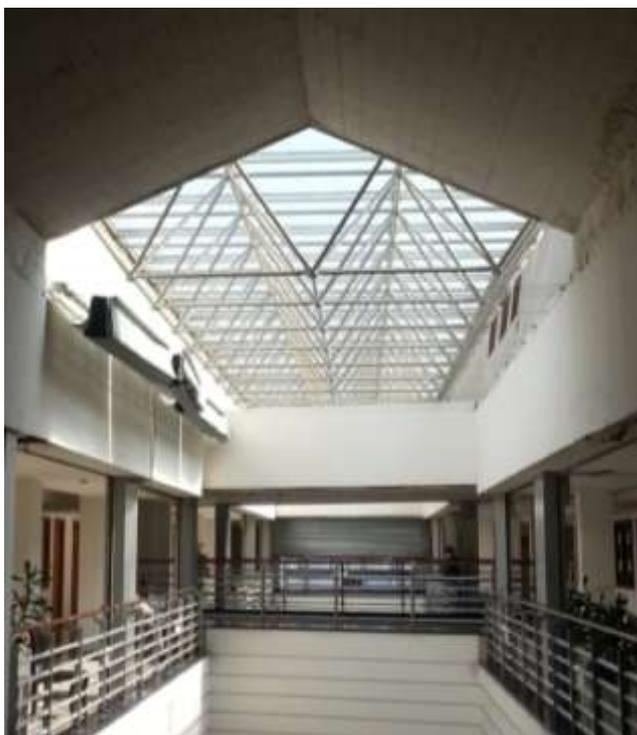
改造后的幕墙中空双面钢化玻璃不仅保证了幕墙整体的安全性，同时与原单片普通玻璃相比：夏季大楼的隔热效果明显提高，增加了开启窗后使空气上下流通，在一定程度上起到了楼面降温目的，而且改善了大楼内的空气质量；在冬季，
